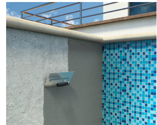
ฉาบกันรั่วซึมก่อนการปูกระเบื้อง สระว่ายน้ำ
