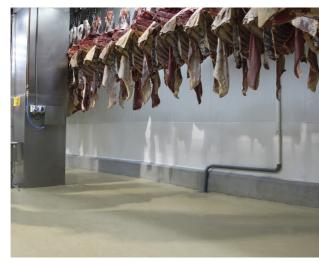
Three part, water dispersed high strength coloured polyurethane modified, cement and aggregate screed โพลียูรีเทนซีเมนต์ 3 ส่วนผสม สำหรับงานประระดับด้วยตัวเอง งานทำความหนา และงานทาเคลือบ เหมาะสำหรับอุตสาหกรรมอาหาร
