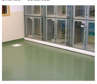
One part, preblended, coloured mineral dry shake hardener One part, coloured solvent based acrylic resin polymer for concrete comprising of cement, specially selected quartz solution used to cure, harden and seal fresh or hardened concrete อะคริลิคโพลีเมอร์สำหรับทาเคลือบพื้นเพื่อคณสมบัติกันฝนและช่วยบ่ม เหมาะสำหรับพื้นที่ทางเดิน
