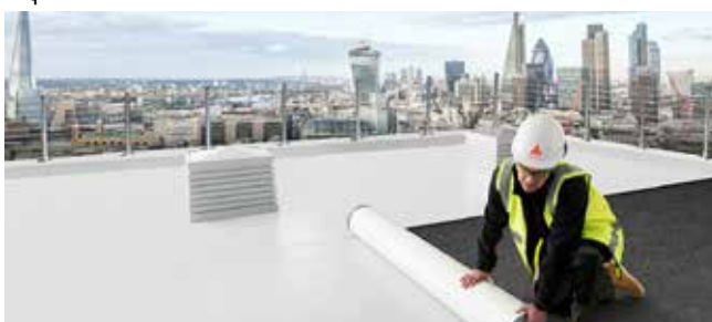
กลุ่มระบบงานหลังคา
