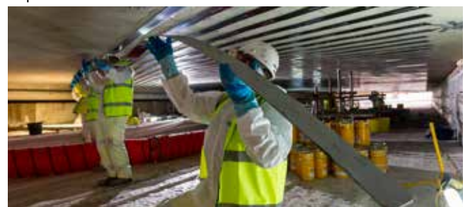
กลุ่มระบบงานซ่อมแซมคอนกรีต
