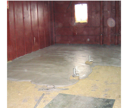
ระบบปรับระดับพื้นที่ป้องกันการหน่วงไฟประเภทชั้น A60
