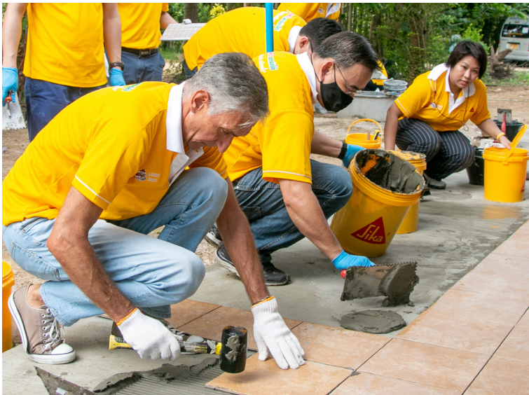
๑ ปูกระเบื้องพื้นบริเวณห้องน้ำ
