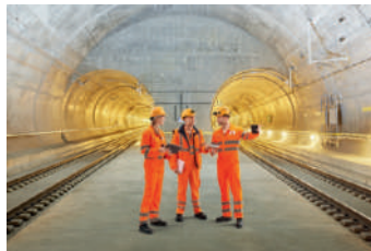
WATERPROOFING ธุรกิจงานกันซึมทั่วไป
